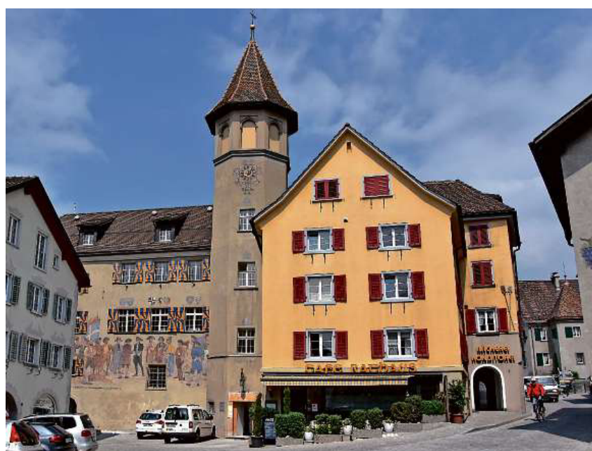
Im alten Rathaus in Maienfeld entstehen Unterrichtsräume und ein Atelier für die künftigen Studierenden der Schule für Gestaltung Graubünden. Bild Stefanie Studer
